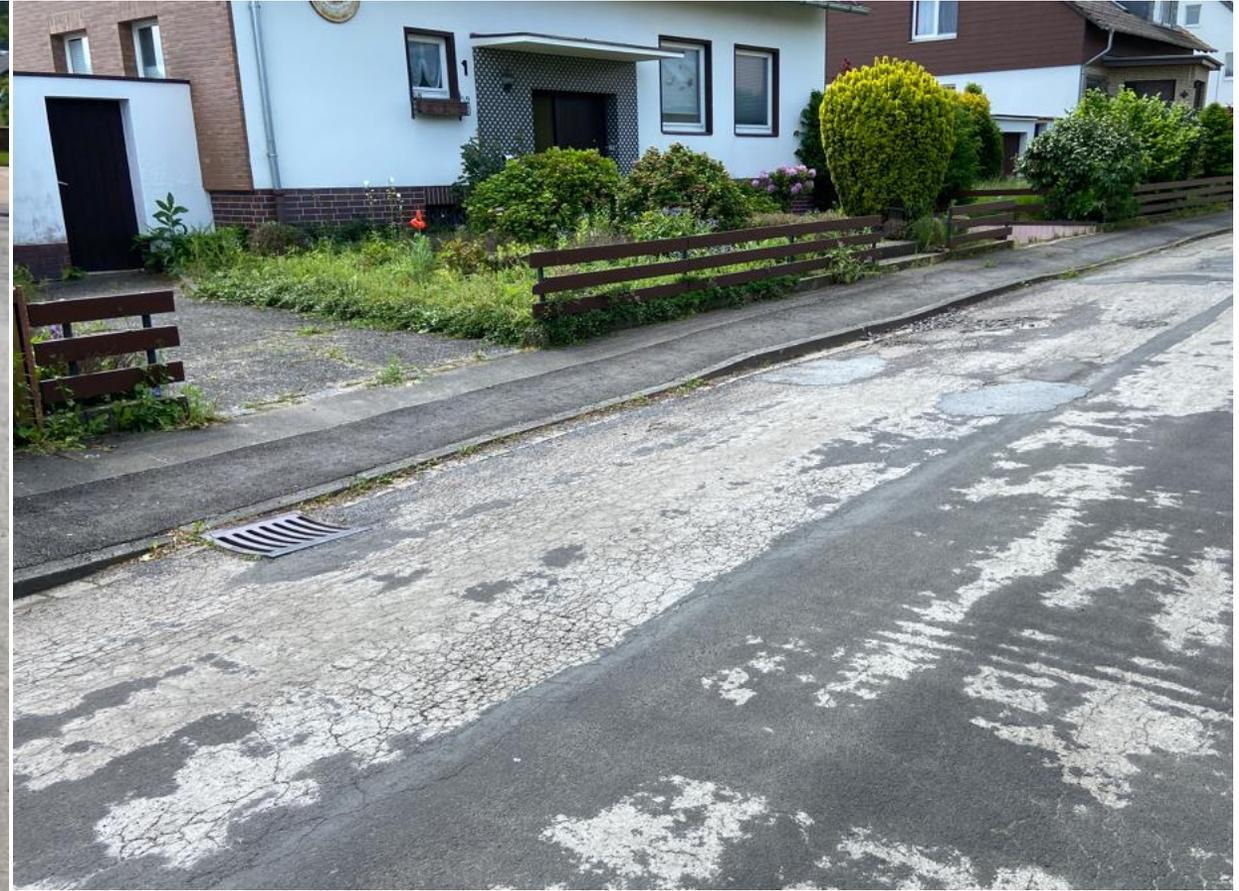
**Risse, Setzungen, Beschädigungen, viele Reparaturstellen, kein tragfähiger Untergrund**
