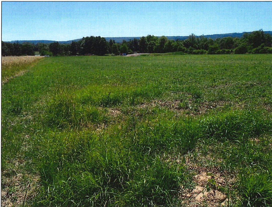
Foto: Blick über die Untersuchungsfläche von Nord nach Süd mit dem bodenmodellierten Rohbau der Skateanlage im Hintergrund / 23.06.2022
